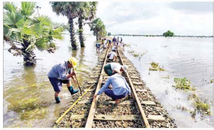
ပုသိမ်-ဟင်္သာတ-ကြိတ်ခင်းရထားလမ်းပိုင်းအတွင်း ရေကြီး/ရေလျှံမှုဖြစ်စဉ်ကြောင့် ရထားလမ်းနှင့် တံတားများ ထိခိုက်ပျက်စီးမှုများကို စစ်ဆေးပြုပြင်နေစဉ်။
