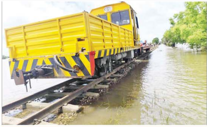
ပုသိမ်-ဟင်္သာတ-ကြိတ်ခင်းရထားလမ်းပိုင်းအတွင်း ရေကြီး/ရေလျှံမှုဖြစ်စဉ်ကြောင့် ရထားလမ်းနှင့် တံတားများ ထိခိုက်ပျက်စီးမှုများကို စစ်ဆေးပြုပြင်နေစဉ်။
