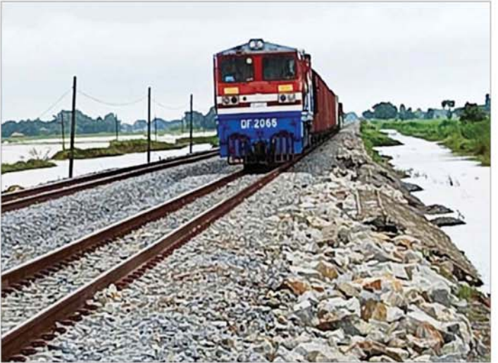
ရန်ကုန်-မန္တလေး ရထားလမ်းပိုင်း၊ ပဲခူး-ရွှေလှေအကြား ရထားလမ်းတာဝေါင်ရေတိုက်စားထားသော နေရာများအား ကျောက်ကြီးများချယူစီထည့်ပြင်ပြီးစီးမှုကို တွေ့ရစဉ်။
