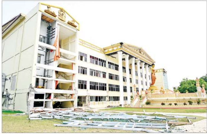
သီတဂူသံဃာသင်္ဃာတကျောင်းဆောင်တော်ကြီး ငလျင်ဘေးဒဏ်ကြောင့် ထိခိုက်ပျက်စီးခဲ့မှုကို ရွှေ့ရစဉ်။
