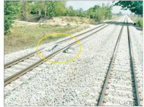
ရန်ကုန်-မန္တလေးရထားလမ်းပိုင်းအတွင်းရှိ ညောင်ခြေထောက်နှင့် ကျွဲပွဲဘူတာအကြား အဆန်ရထားလမ်းပေါ်၌ အကြမ်းဖက်သောင်းကျန်းသူအဖွဲ့က မိုင်းထောင်ဖောက်ခွဲဖျက်ဆီးမှုကြောင့် ရထားလမ်းပျက်စီးမှုအခြေအနေမှတ်တမ်းဓာတ်ပုံ။
